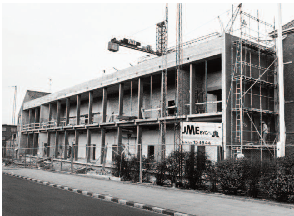
Byggeriet af den nye retsbygning bag ved politigården skyder raskt frem i midten af november 1975. Rettens afdelinger var på dette tidspunkt spredt på forskellige adresser i byen. Først i november blev bygningen taget i brug. EBA 36841-019
